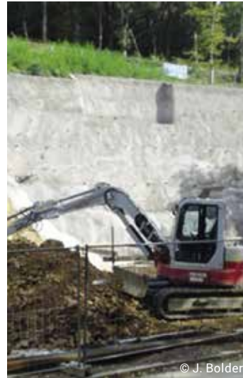
Baustelle Kreuzkopfstraße am 01.10.17
