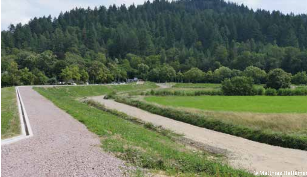
Erweitertes Hochwasserrückhaltebecken Wonnhalde
