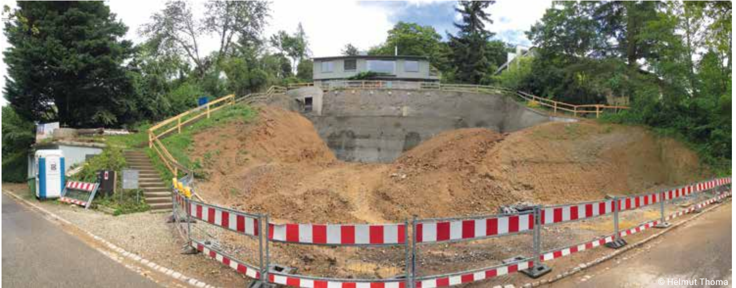
Ausgehöhlter Berg – Baugrube in der Kreuzkopfstr. 11
