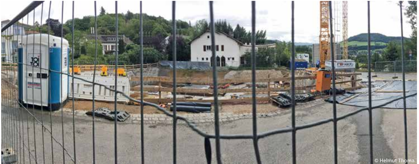
Im Kapellenweg 18 umfasst die Baugrube fast die gesamte Grundstückfläche
