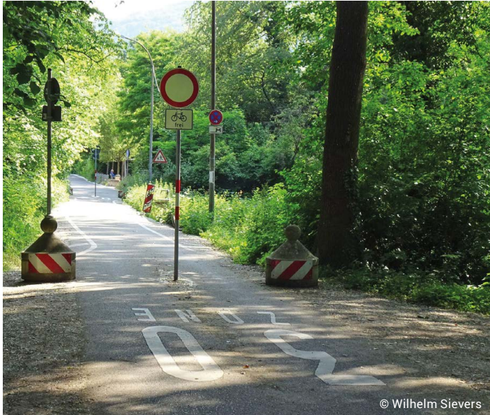
Sperrung der Brücke im Süden der Schlierbergstraße. Neubau im Herbst?
