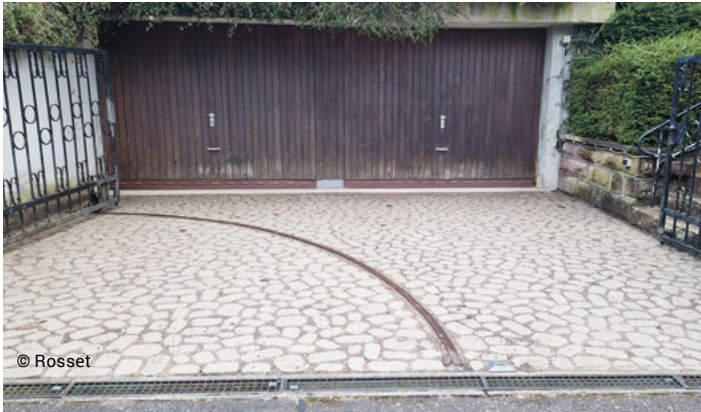
Und so könnte auch Ihre Einfahrt demnächst aussehen: Regenwasser kann besser versickern
